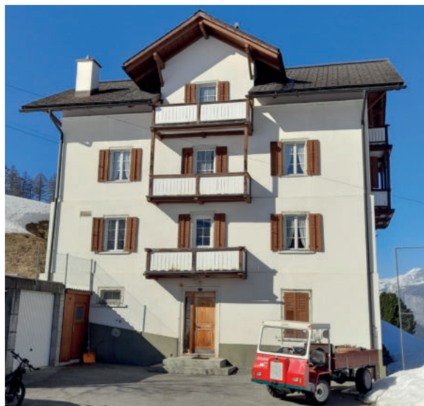
Ferienlagerhaus Praden +41 79 625 66 30 praden@blaueskreuz.gr.ch
